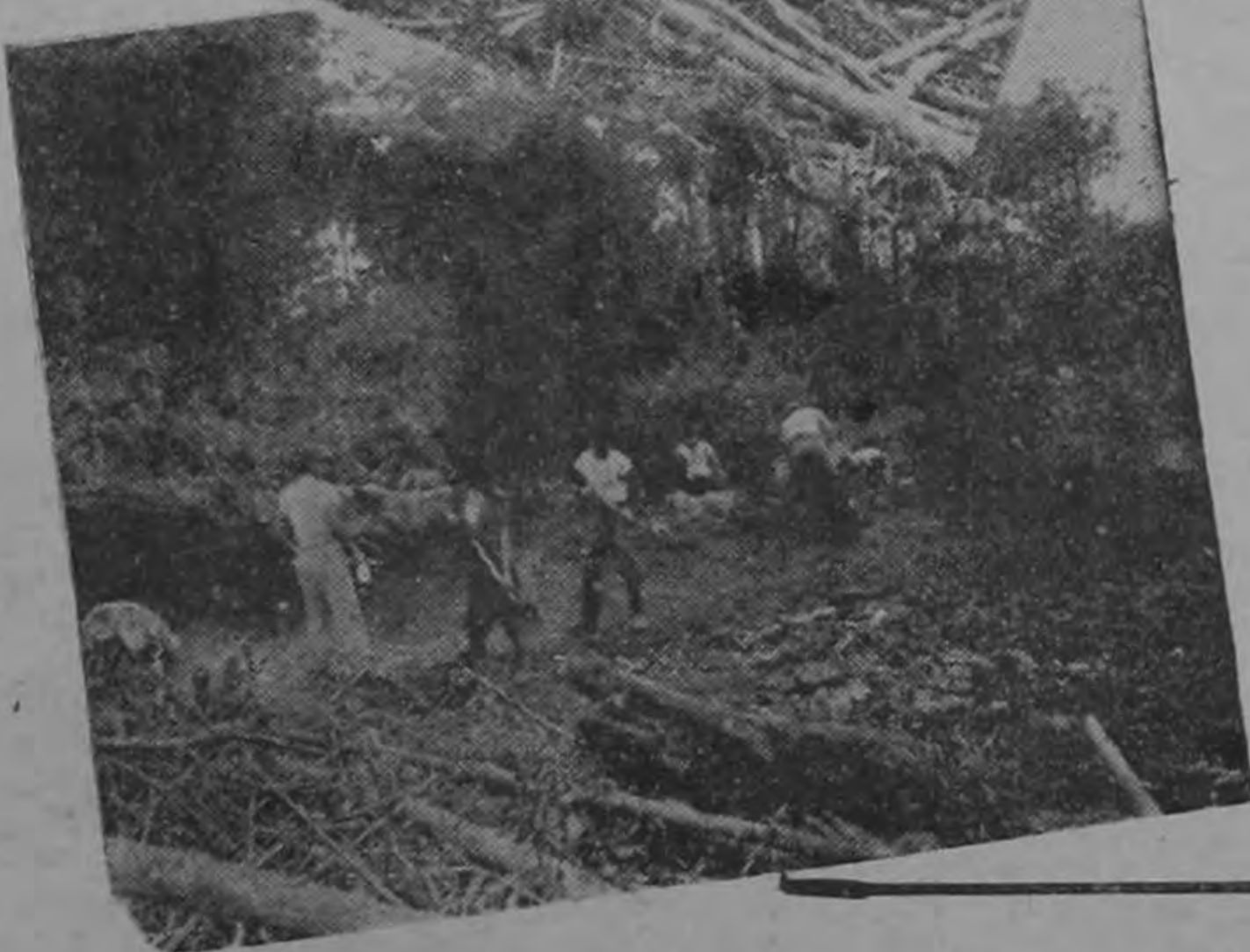
Construyendo caminos de acceso a las parcelas
