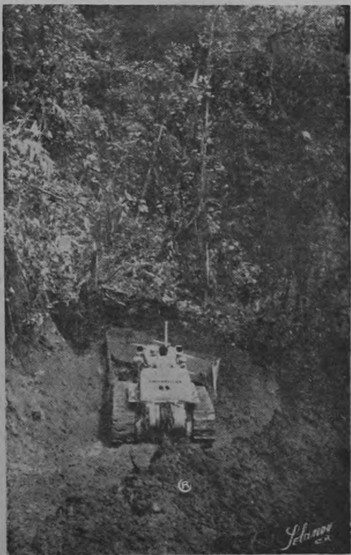
El tractor no se detiene un momento. Manejado por hábiles manos, abre brecha en el monte firme, para construir la carretera que llevará directamente a la parcelación.
